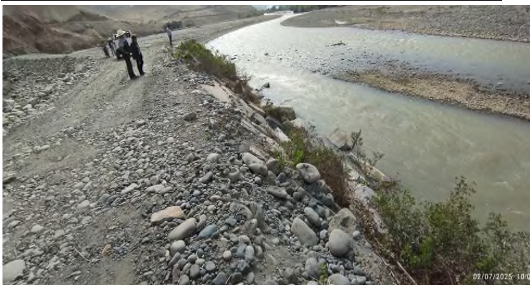
FIGURA N°02: TRAMO CRITICO 03, , PERDIDA DE PROTECCION DE ENROCADO EN SU BASE,
