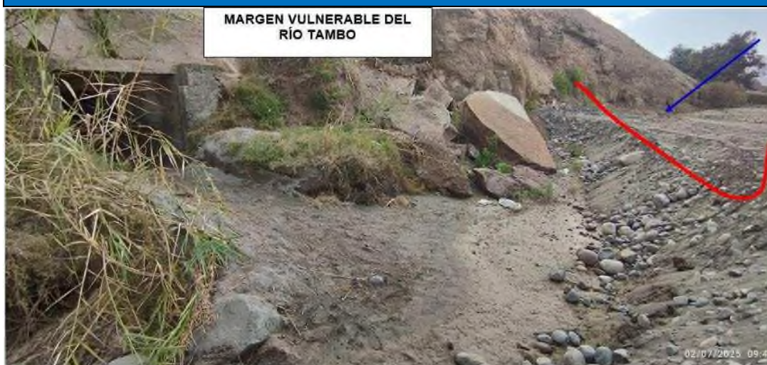
FIGURA N°01: TRAMO 01 INICIO DE ACTIVIDADES, ACCESO A TUNEL DE CANAL EXPUESTO A INGRESO DE RIO TAMBO
